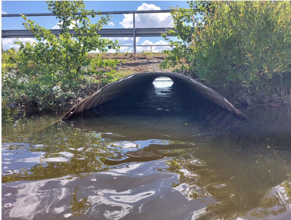
Kuva 12: Kutilan sillan sivuaukko eteläpuolen suunnasta katsottuna (Paavo Vartiainen, 2022)
