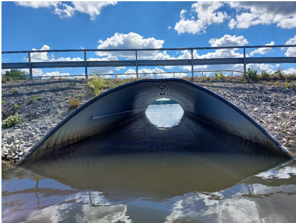
Kuva 11: Kutilan sillan pääaukko kuvattuna luoteen puolelta katsottuna (Paavo Vartiainen, 2022)
