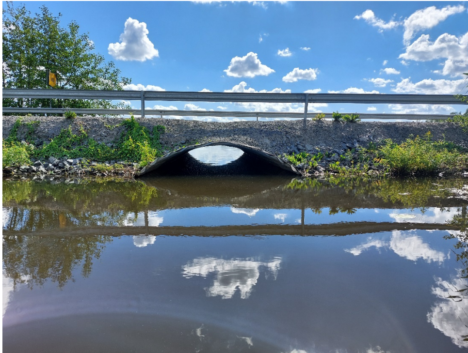
Kuva 13: Unosten sillan tuloaukko eteläpuolen suunnasta katsottuna (Paavo Vartiainen, 2022)
